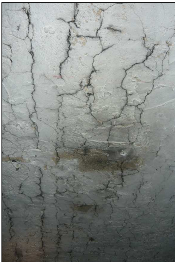
Fot. 17 Fot. 18. Widok spękań sufitu w piwnicy oraz zawilgocenie stropu nad parterem.
