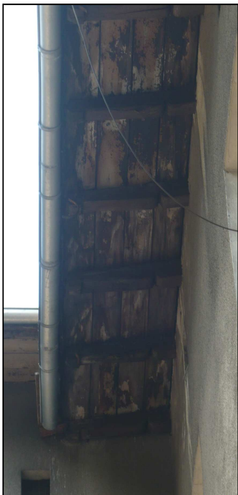
Fot. 6, Fot. 7 Budynek przy ul. Dąbrówki 8. Korozja biologiczna więźby dachowej, spękania tynków na kominie.
