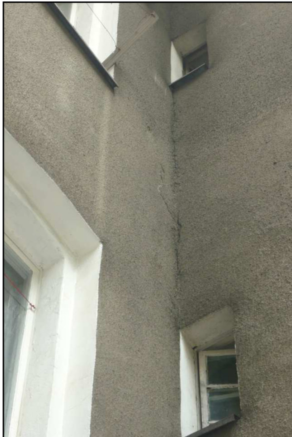
Fot. 13 Fot. 14 Budynek przy ul. Dąbrówki 8. Rysy i pęknięcia na elewacji.
