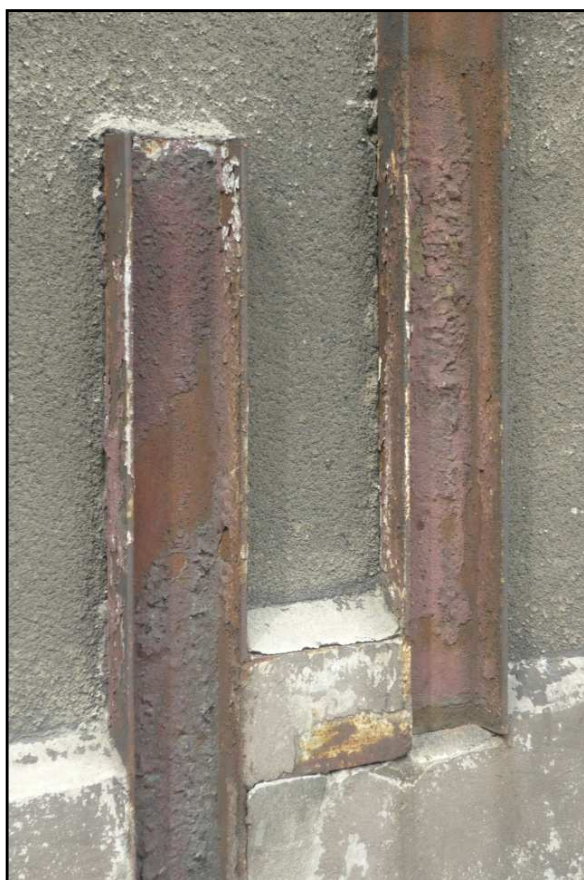
Fot. 15, Fot. 16 Budynek przy ul. Dąbrówki 8. Korozja elementów stalowych, brak ciągłości rury spustowej.
